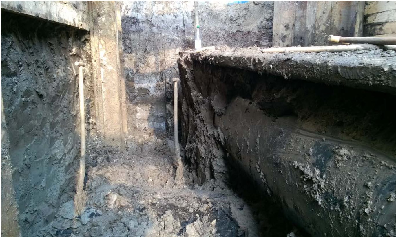
Freilegen der Leitung im Kleiboden
