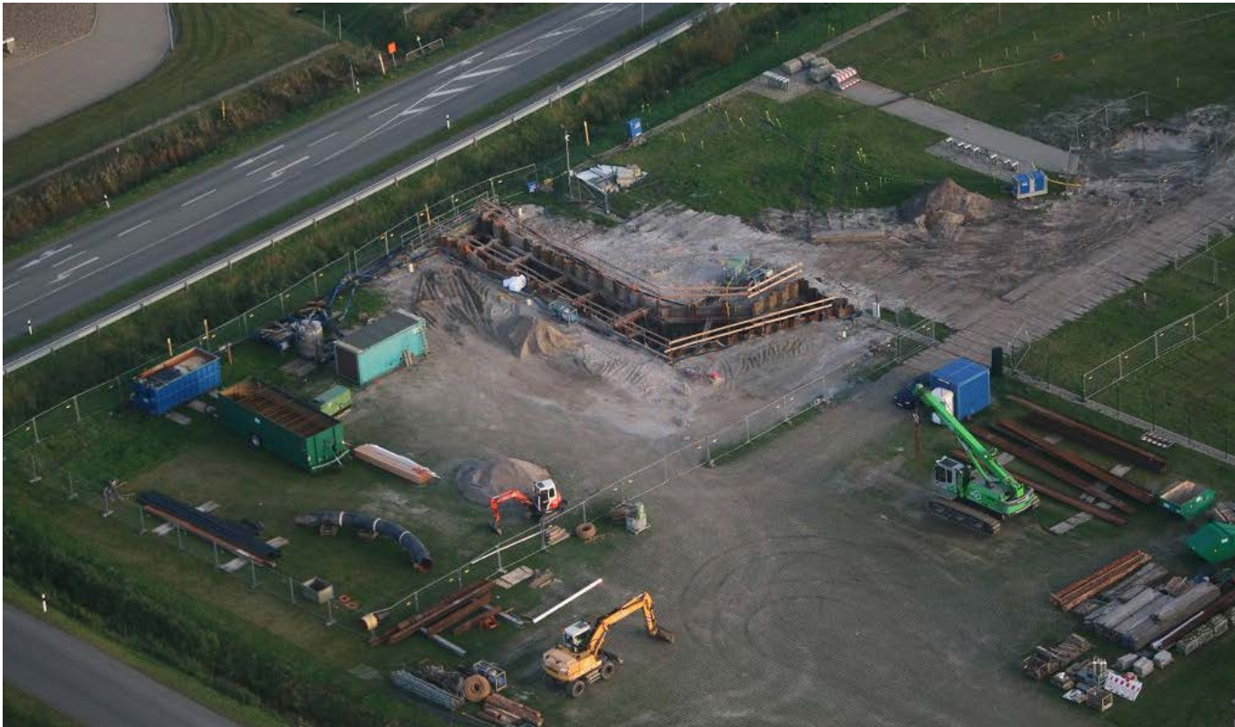
Luftaufnahme der Baugrube
