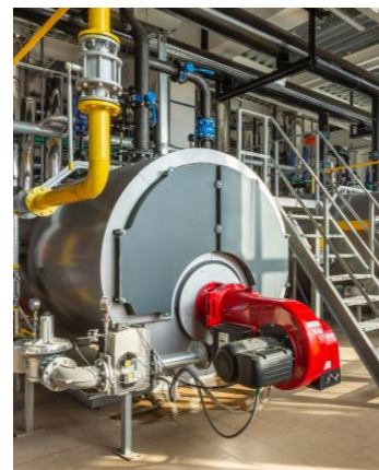
Spitzenlastkessel (Erdgas)
