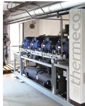
Wärmepumpe
