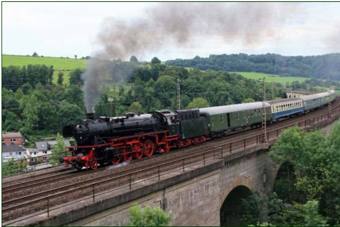
Eisenbahnhistorie auf dem Altenbekener Bekeviadukt (von der Aussichtsplattform aus aufgenommen im Juli 2007)
