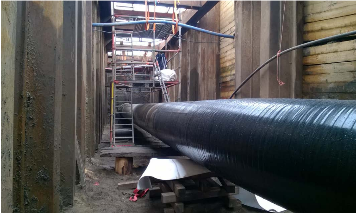
Baugrubensohle mit Holzaufleger
