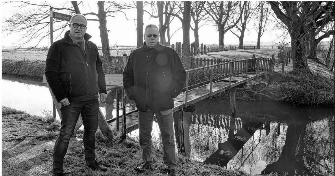
Bürgermeister Hans-Peter Heikens (links) und der stellvertretende Bürgermeister Helmut Plöger stellten gestern erste Pläne für eine neue Fußgängerbrücke über das Jemgumer Sieltief vor. Das alte Bauwerk (Bild) ist marode. Es wurde im Frühjahr 2016 gesperrt.
