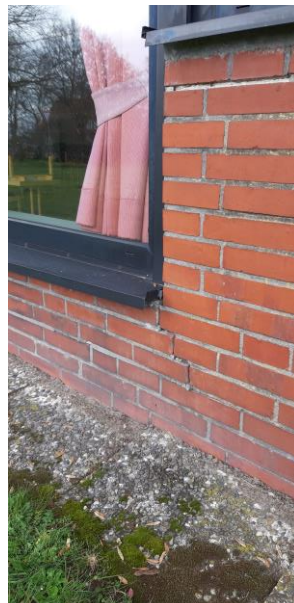
Abb. 36) Südfassade Achse K/20
