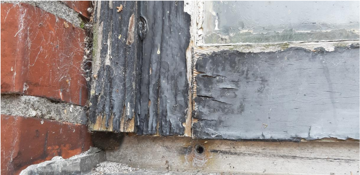
Abb. 29) Fenster Hausmeisterwohnung, Nordfassade
