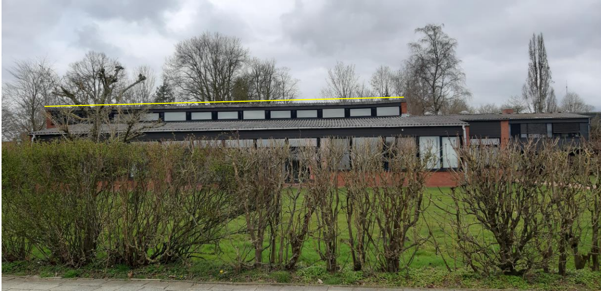
Abb. 46) Südfassade, Achse J, Dach Gemeindesaal
