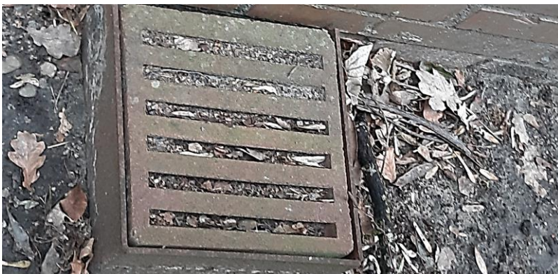
Abb. 19) Lüftungsöffnung Kriechkeller, Achse K
