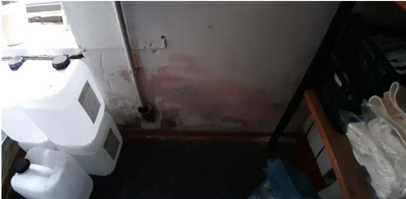
Abb. 42) Außenwand, Achse J
