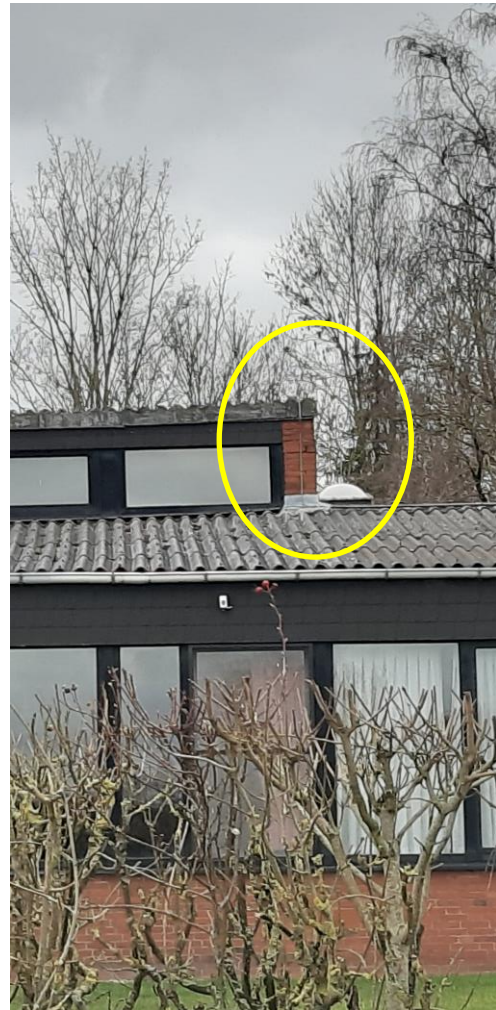
Abb. 39) Giebel Ostfassade, Achse 20
