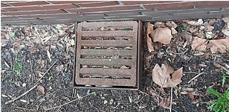
Abb. 18) Lüftungsöffnung Kriechkeller, Achse A
