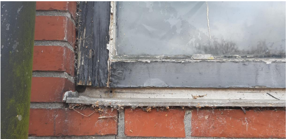
Abb. 30) Fenster Hausmeisterwohnung, Nordfassade
