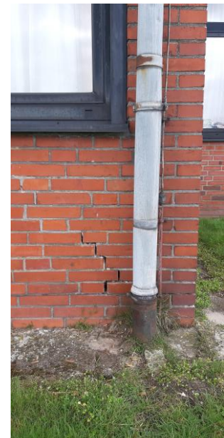
Abb. 37) Südfassade Achse K/21
