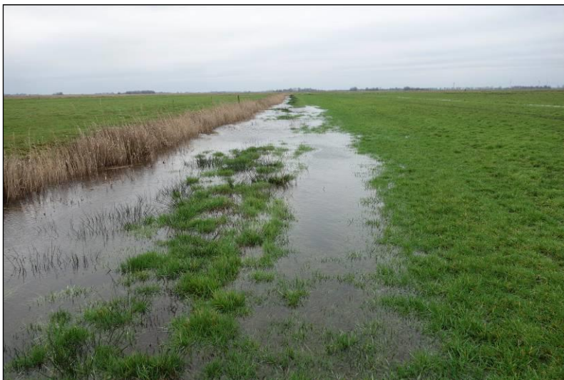
Abbildung 5: Das hoch anstehende Wasser tritt am Graben an der Nordseite des Flurstückes 22 teilweise über das Ufer (20.01.2021).
