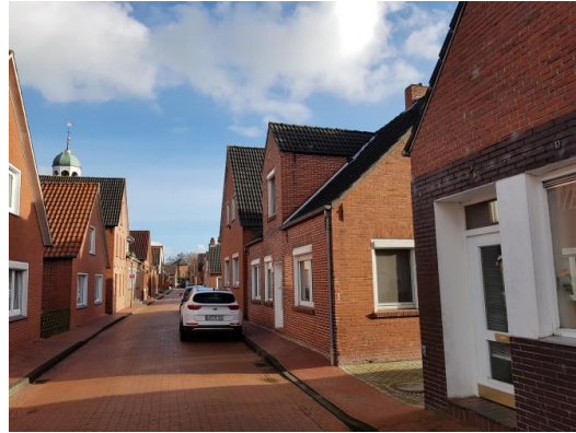
Abbildung 12: Die Kleinteiligkeit der Gebäude und Grundstücke zeigt die Vergangenheit von Jemgum
