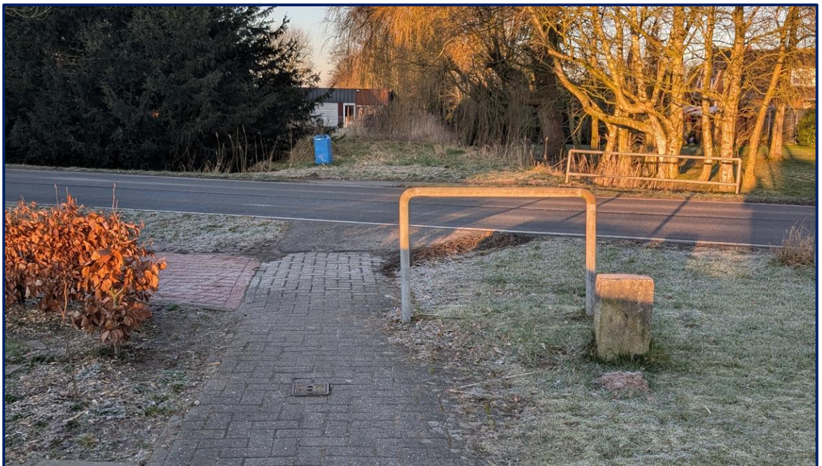
Abbildung 4: Nördliche Querung, aus Richtung Lorenweg / Osten kommend gesehen.
