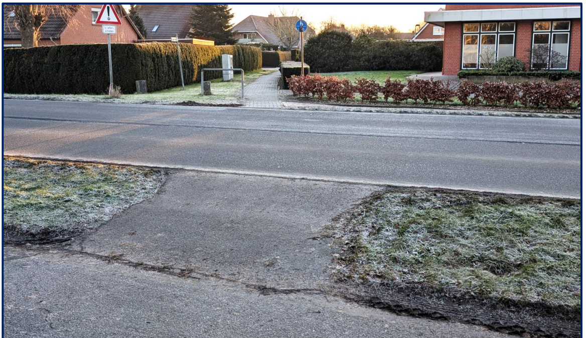
Abbildung 4: Nördliche Querung, von Westen aus gesehen
