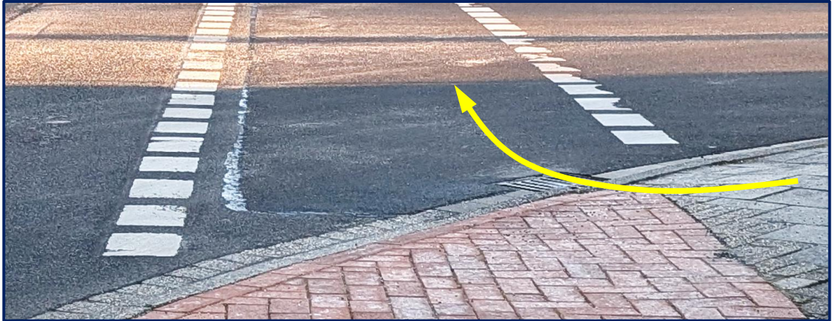
Abbildung 3: Straßenablauf im Furtbereich mit möglicher Trajektorie eines Rollatorrades
