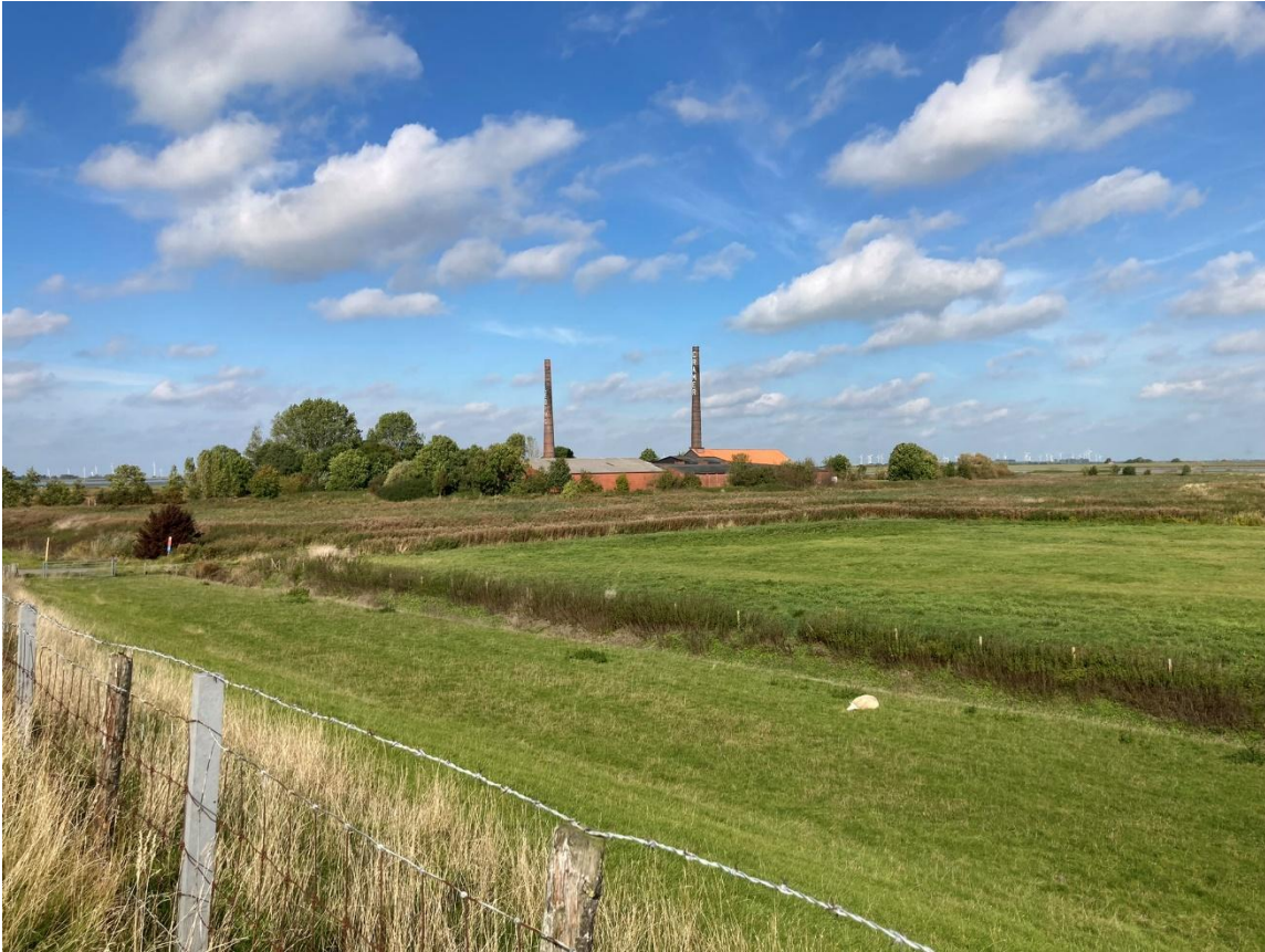
Abbildung 1: Blick auf die Ziegelei von Südosten
