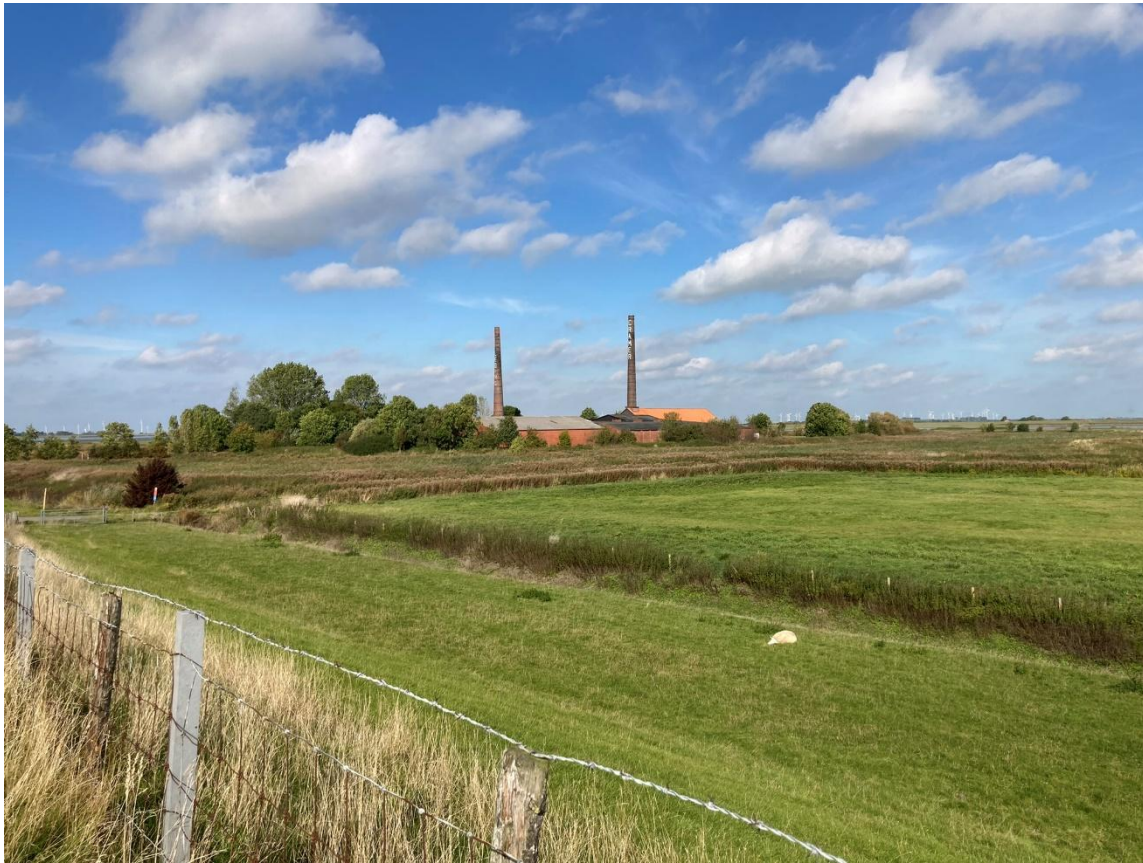
Abbildung 1: Blick auf die Ziegelei von Südosten
