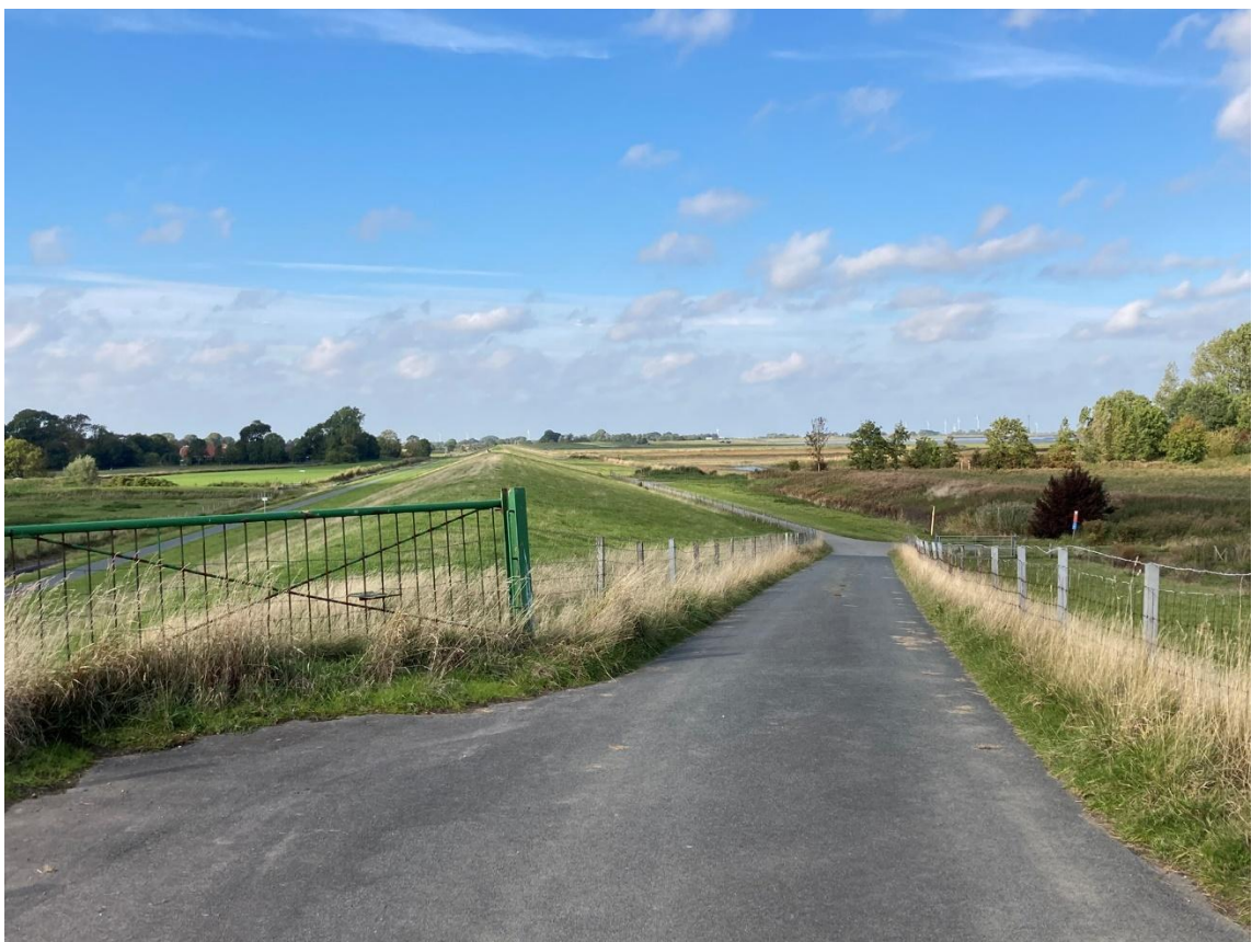
Abbildung 2: Blick auf den Deich
