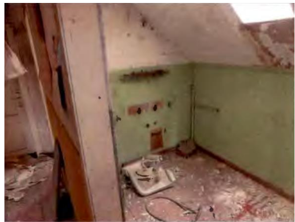
Ansicht ehem. Bad (DG)
