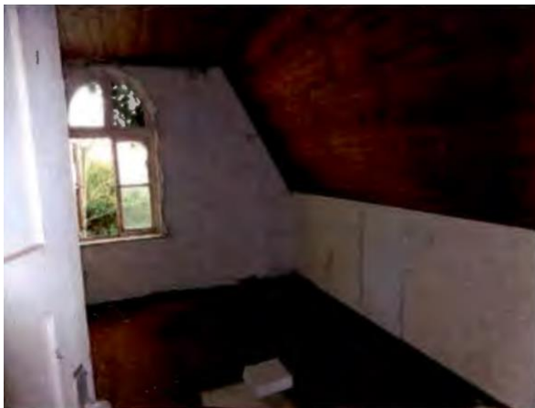
Ansicht Zimmer (DG)
