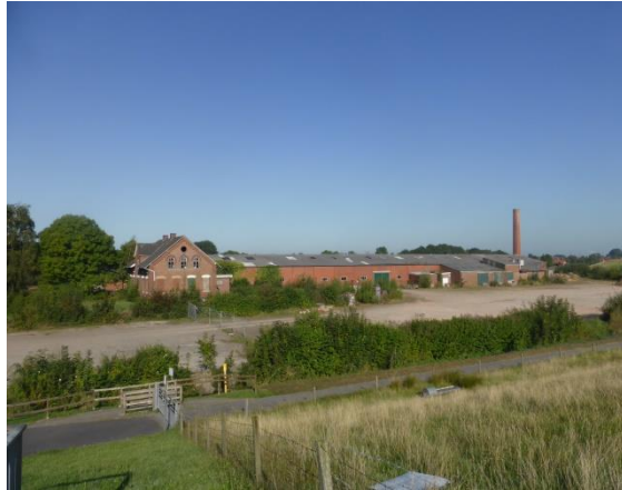
Abbildung 26: Braches Ziegeleigelände Reins
